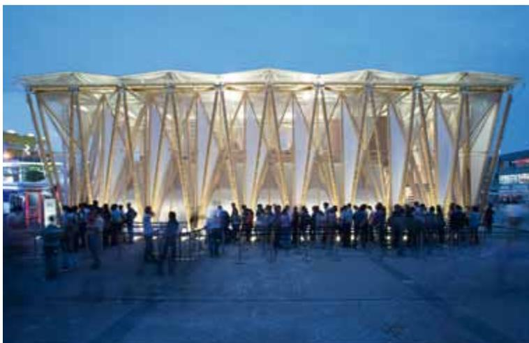
Deutsch-Chinesisches Haus auf der Expo 2010: Bambuskonstruktion verstärkt mit Beton aus recycelter Flugasche
