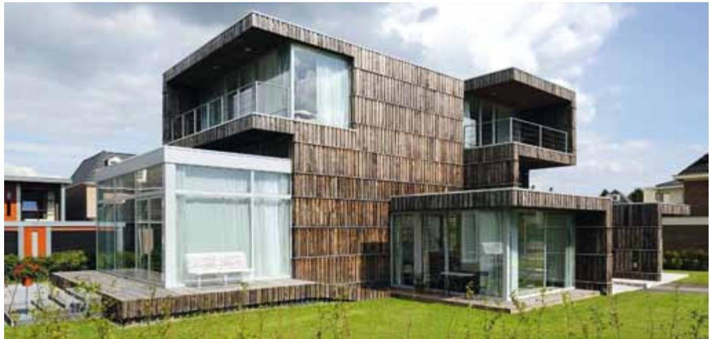
Upcycling am Bau der Villa Welpeloo: Fassade aus Holz alter Kabelrollen
