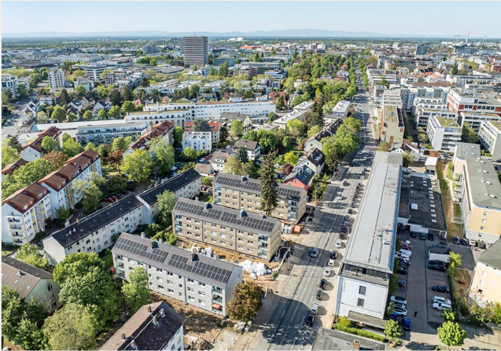
Fertiggestelltes Pilotprojekt der bauverein AG am Donnersbergring
