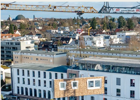
... industriell vorgefertigten, passgenauen Fassadenelementen.
