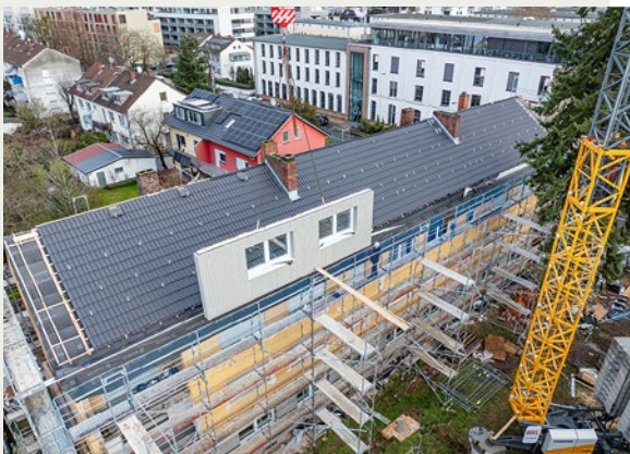
Bauphasen des Pilotprojektes: Energetische Sanierung mit ...
