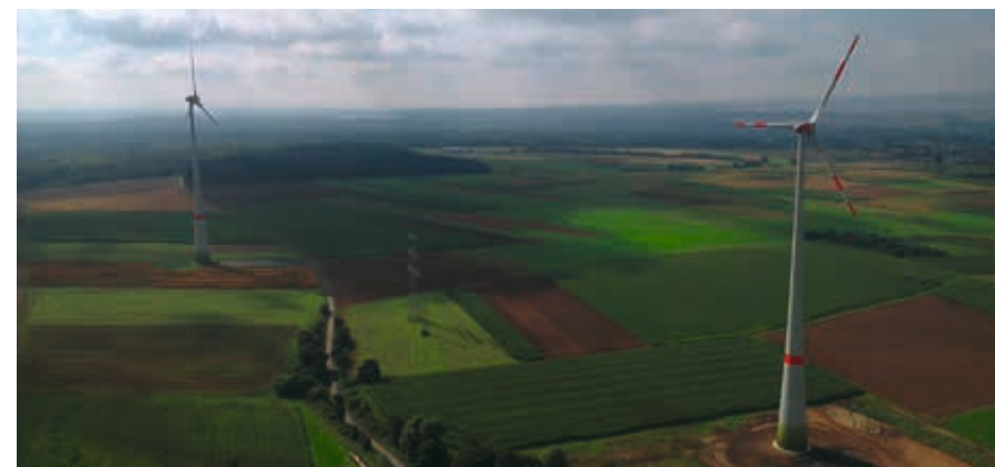
Im November 2012 nahm die HEAG den Windpark Erksdorf mit knapp sieben Megawatt Leistung in Betrieb.
