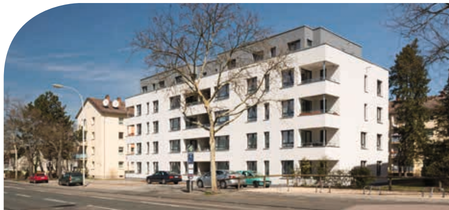
19 neue geförderte Wohnungen der bauverein AG in der Rüdesheimer Straße.
