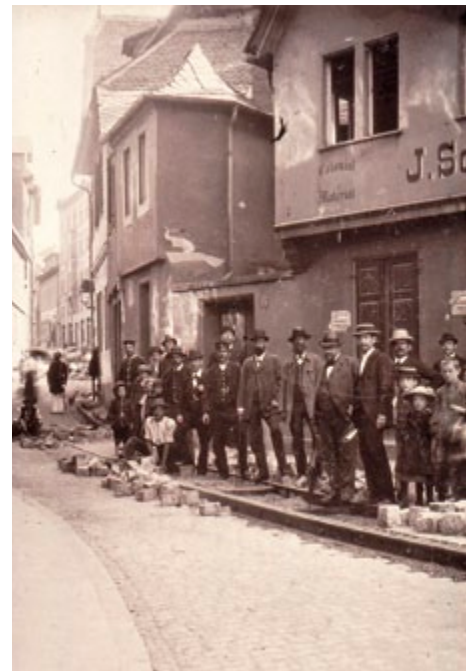
Verlegung der Schienen für die elektrische Straßenbahn in der Kirchstraße, 1897
