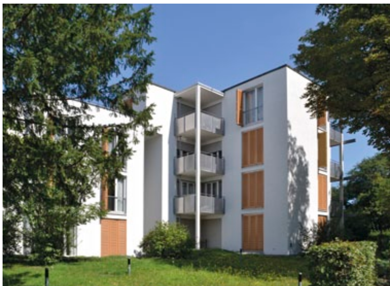
Gebäudekomplex in der Holzhofallee/Schepp Allee
