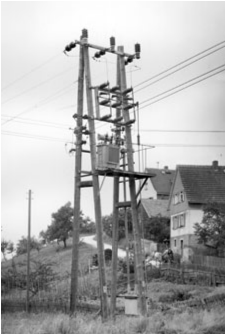
Alte Ortsnetzstation Erlenbach im Juli 1955, vermutlich Vorkriegszustand
