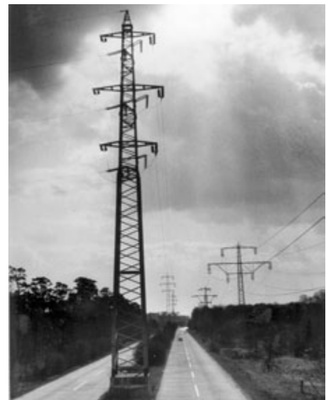
Eckmast der 110/20-KV-Leitung Darmstadt-Heppenheim auf dem Mittelstreifen der A5, 1957
