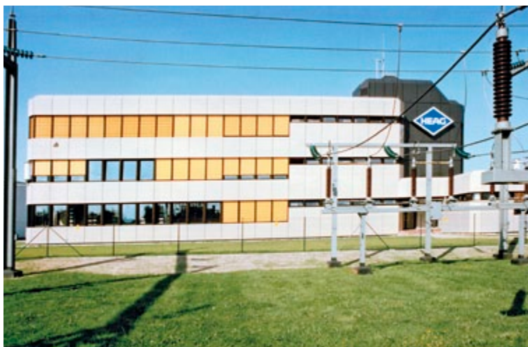
Neubau der Verwaltung der Betriebsleitung Heppenheim, 1985
