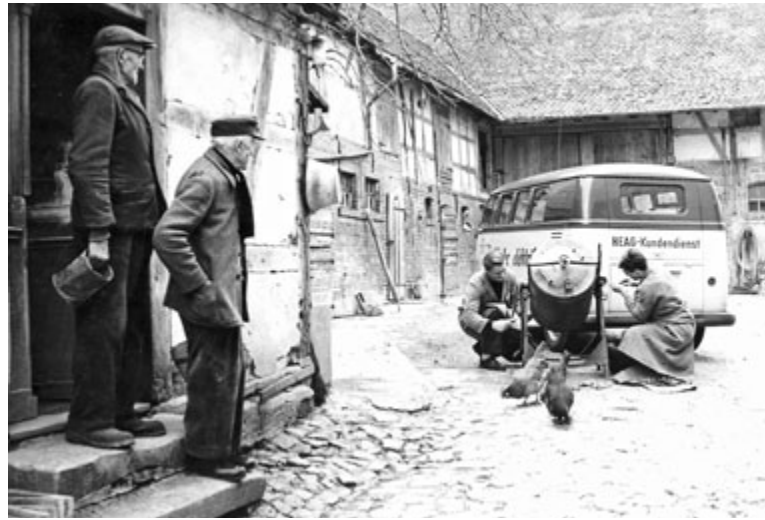
Mitarbeiter des HEAG-Kundendienstes reparieren einen Futterdämpfer, Spachbrücken März 1962
