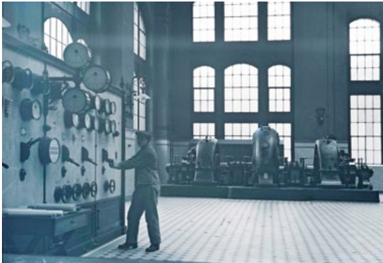
Schalttafel im Maschinenhaus des erweiterten Elektrizitätswerks an der Schuchardstraße (heute Centralstation), 1905
