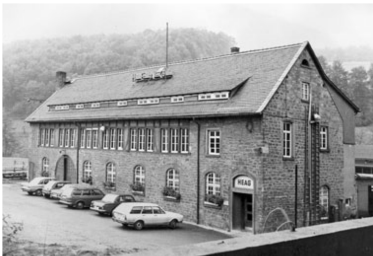
Altes Gebäude der Betriebsleitung Erbach vor dem Abbruch 1975; bis 1928 Verwaltungsgebäude des Elektrizitätswerks Erbach
