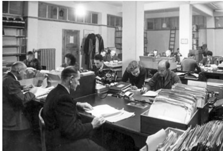
Abrechnung des Stromverbrauchs in der HEAG-Verwaltung, Luisenstraße, 1949
