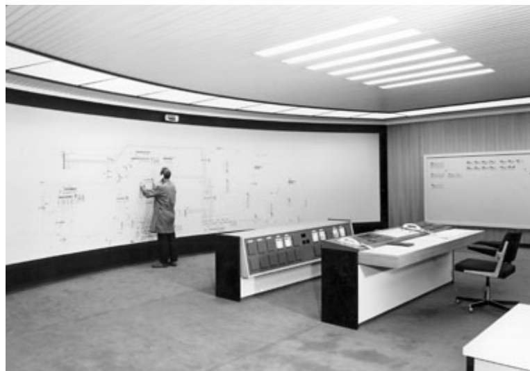
Neue Hauptschaltwarte am Dornheimer Weg, 1974
