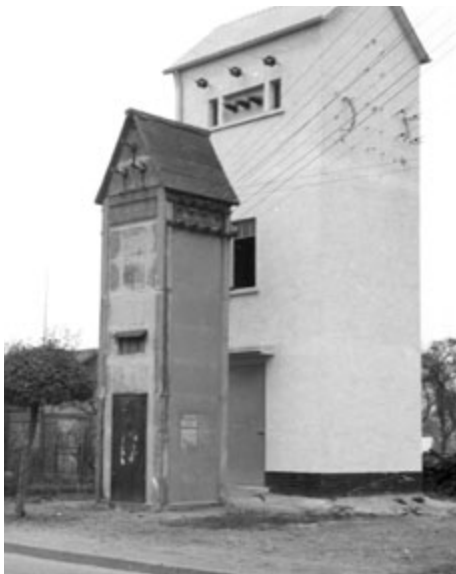
Alte und neue Ortsnetzstation in Hergershausen, Dezember 1953
