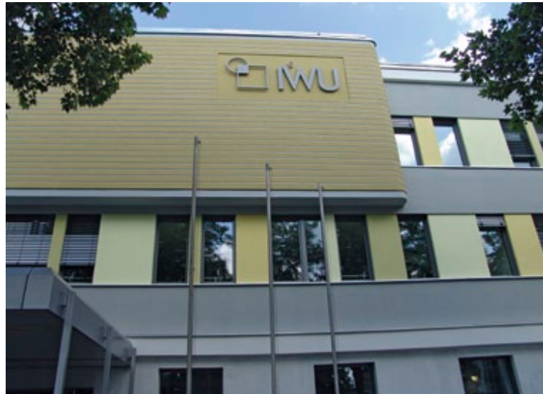
Das ehemalige Landratsamt in der Rheinstraße nach dem Umbau 2011
