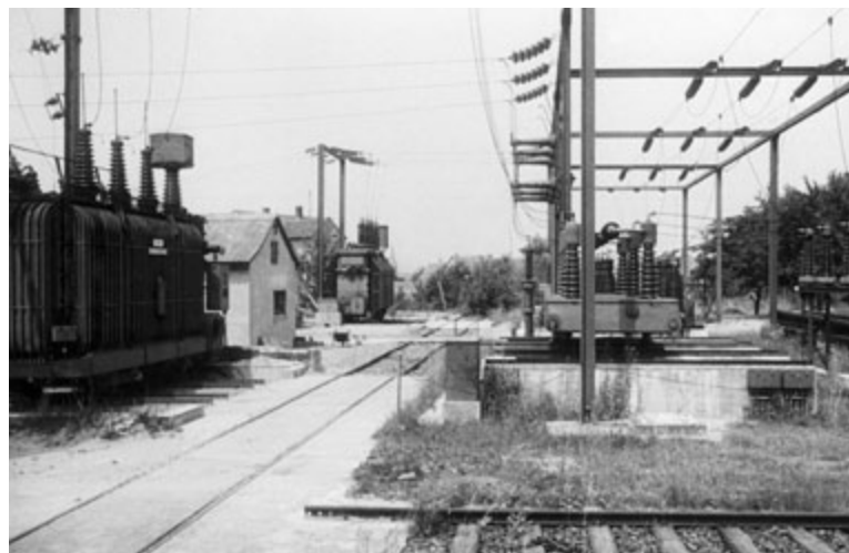
100-KV-Anlage Erbach, von der aus Darmstadt ab 1944 mit Strom versorgt wurde, Zustand am Ende der 1940er Jahre
