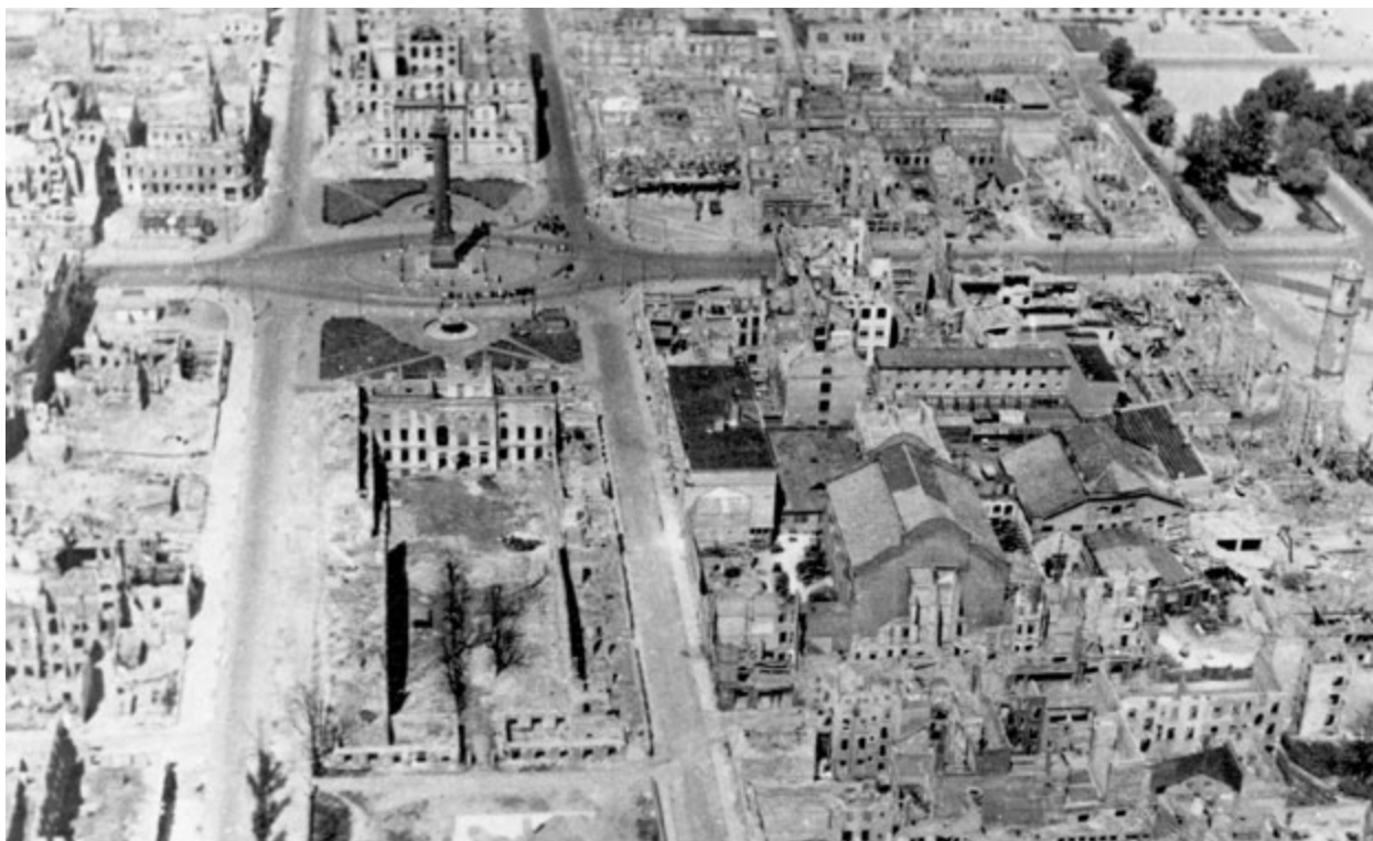
Die zerstörte Innenstadt 1945; Hauptverwaltung, Maschinen- und Kesselhaus der HEAG sind zum Teil erhalten
