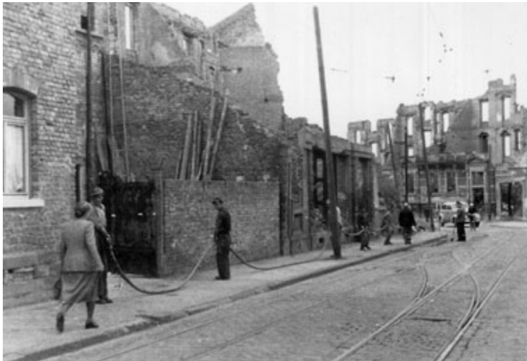
20-KV-Kabelleitung Darmstadt-Roßdorf; Kabelausziehen in der Nieder-Ramstädter Straße, Mai 1949
