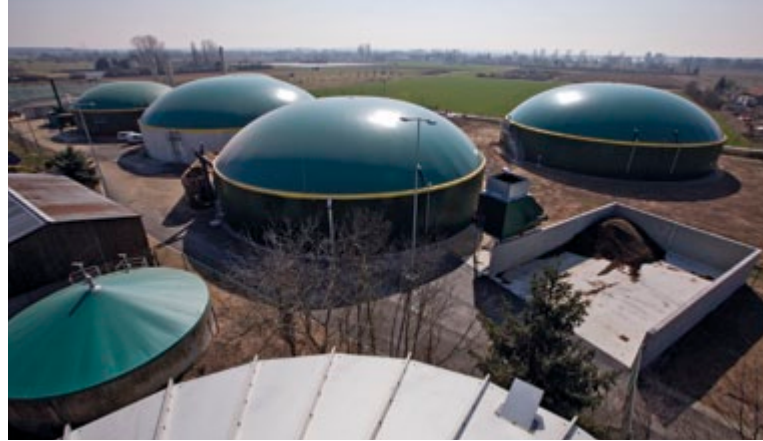
Die Biogasanlage der HSE in Darmstadt-Wixhausen ist die erste in Hessen, die aufbereitetes Biogas ins Erdgasnetz einspeist
