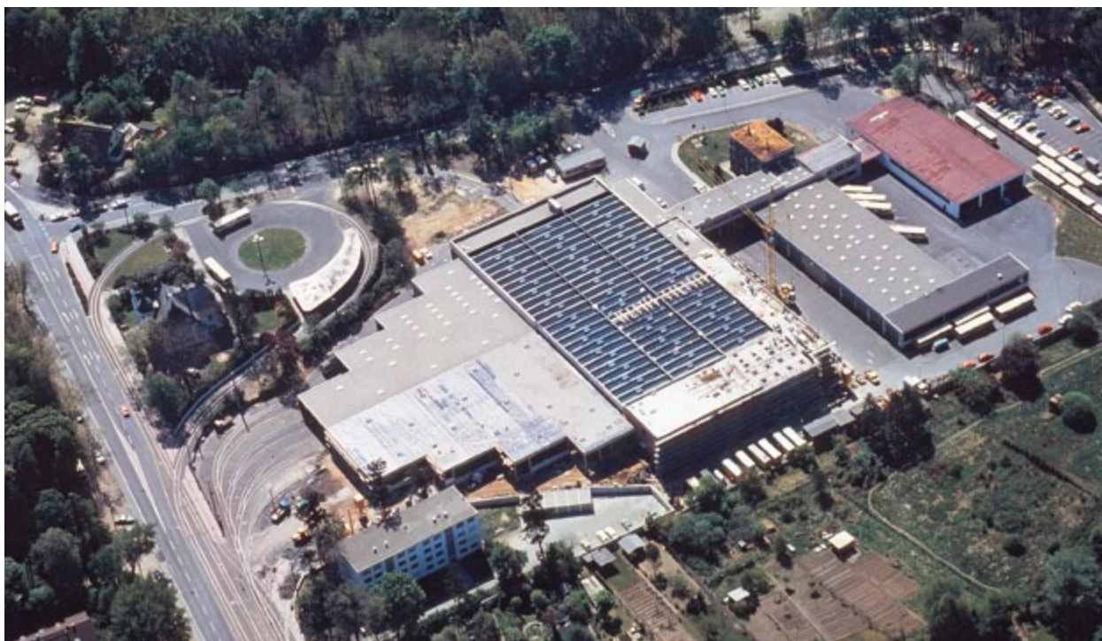
Gelände des HEAG-Verkehrsbetriebs am Böllenfalltor nach Errichtung der neuen Wagen- und Werkstatthallen, Aufnahme 1985
