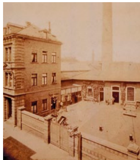
Verwaltungsgebäude und Maschinenhaus der Centralstation an der Schuchardstraße, 1888
