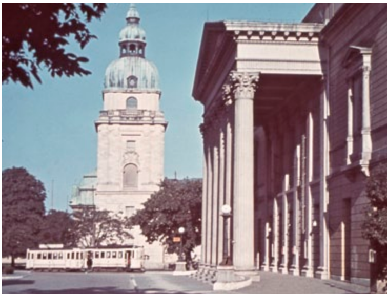
Das in den 1920er Jahren eingerichtete „Theatergleis“, ein Stichgleis für die Besucher des Hessischen Landestheaters
