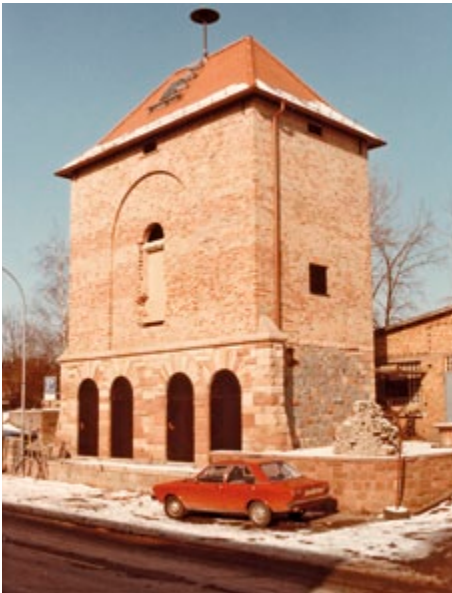
Altes Schalthaus Bensheim, Friedhofsstraße, 1984
