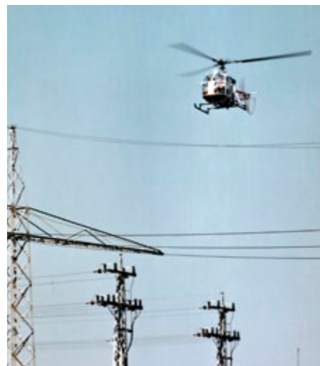
Kontrolle einer 20-KV-Leitung bei Groß-Umstadt per Hubschrauber, 1980
