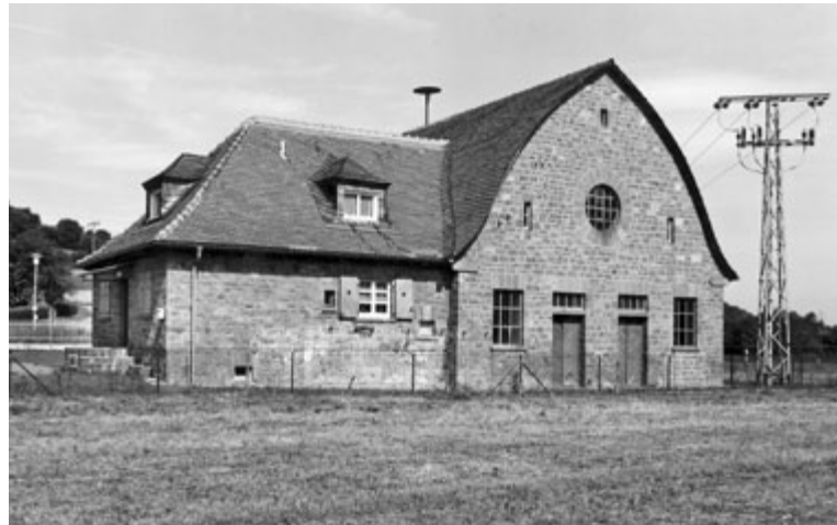
Wasserkraftwerk in Schönnen, 1939 von der HEAG erworben, Aufnahme 1986
