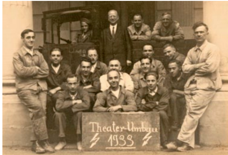
Mitarbeiter der HEAG nach Abschluss der Umstellungsarbeiten im Hessischen Landestheater von Gleich- auf Drehstrom, 1933
