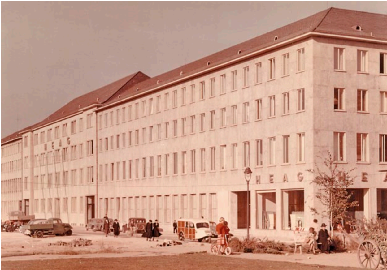
Fassade der neuen HEAG-Hauptverwaltung, 1953
