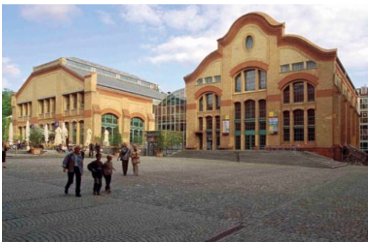
Die ehemaligen HEAG-Hallen A und B nach dem Umbau zur Markthalle und Kulturhalle („Centralstation“), 1999
