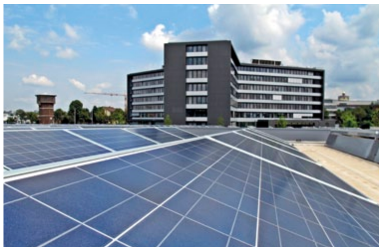
Die Solaranlage der HSE auf dem Dach des städtischen EAD ist die größte in Darmstadt
