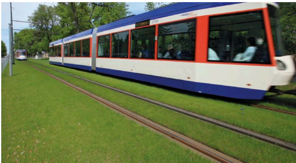
Klimaschutz auf ganzer Linie: Das neue Rasengleis in der Heidelberger Landstraße kommt bei Fahrgästen und Anwohnern gut an
