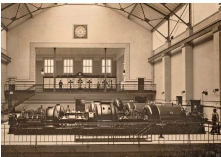
Maschinenhaus des Elektrizitätswerks am Dornheimer Weg, 1909
