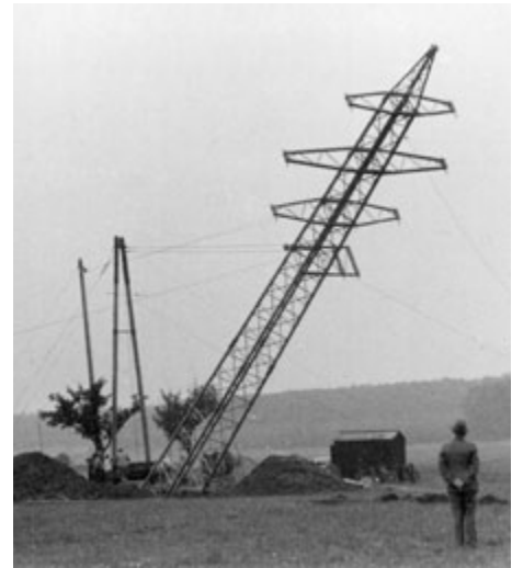
Aufrichtung eines Mastes für eine 20-KV-Leitung bei Roßdorf, September 1949
