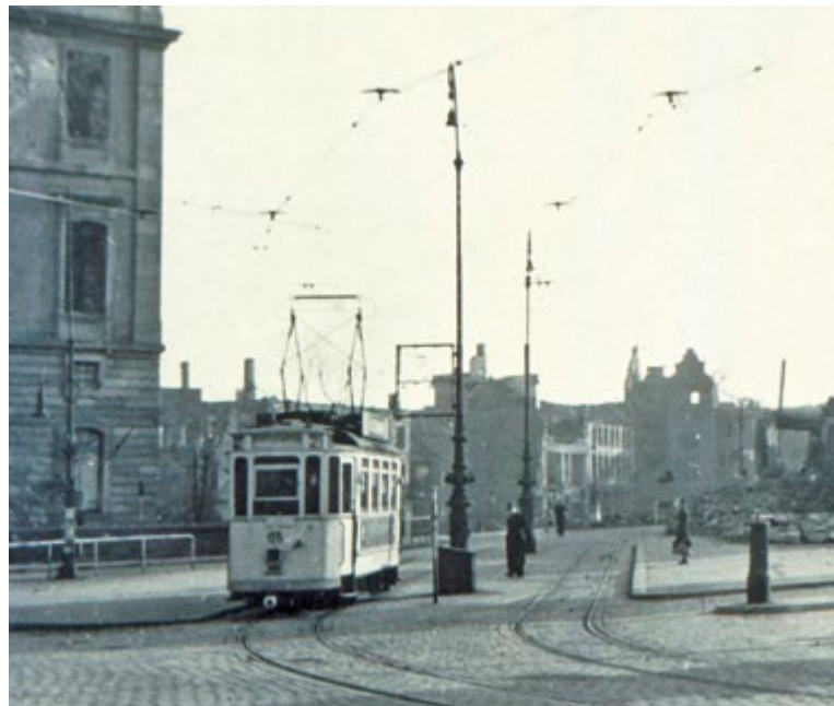
Straßenbahn der Linie 2 an der Haltstelle Schloss, ohne Tarnanstrich, Oktober 1944
