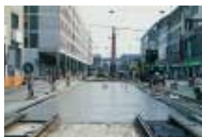
Bauphasen der neuen Nahverkehrs-Trasse.
